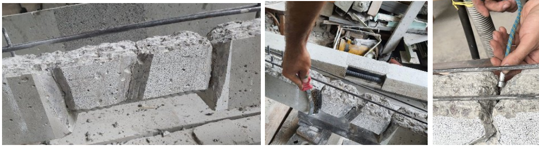
Рис. 2.35. Підготовка тріщин до ін'єктування
