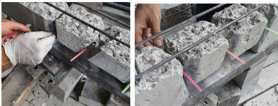
Рис. 2.36. Встановлення пакерів в утворені отвори тріщин
