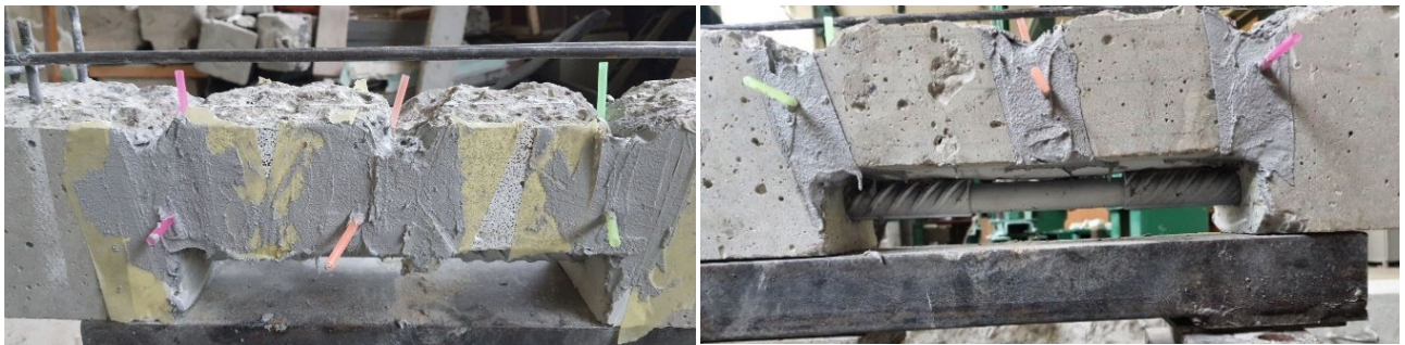
Рис. 2.38. Вигляд зароблених епоксидним клеєм наскрізних тріщини
