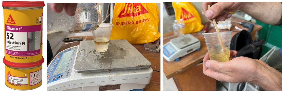
Рис. 2.39. Розмішування Sikadur-52 Injection N
