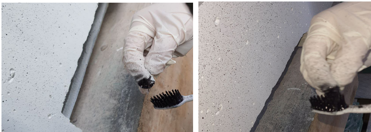
Рис. 2.50. Нанесення спеклів на бетон способом набризку
