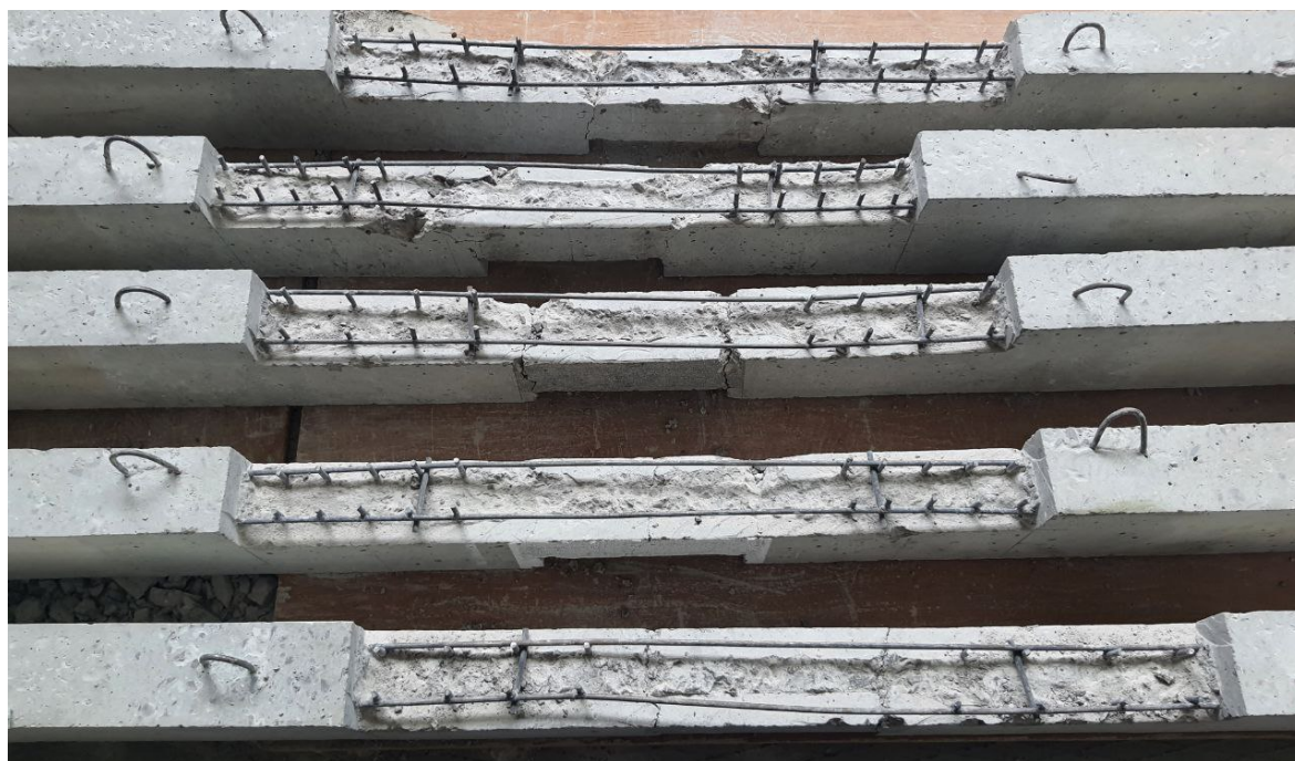
Рис. 2.12. Вирізана пошкоджена ділянка стиснутої зони бетону
