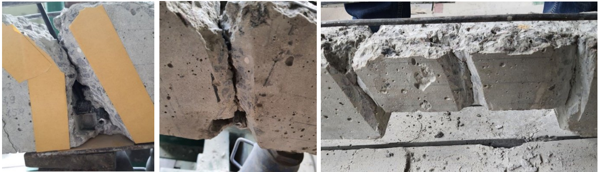
Рис. 2.33. Пошкодження залізобетонних балок вигляді наскрізних тріщин
