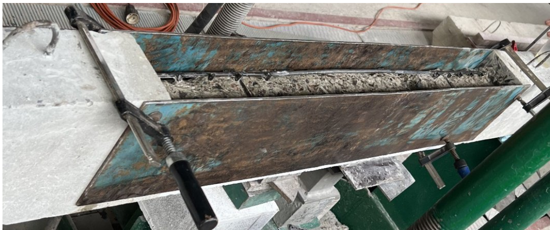
Рис. 2.16. Закріплення опалубки для заливання розчину Sika MonoTop-4012
