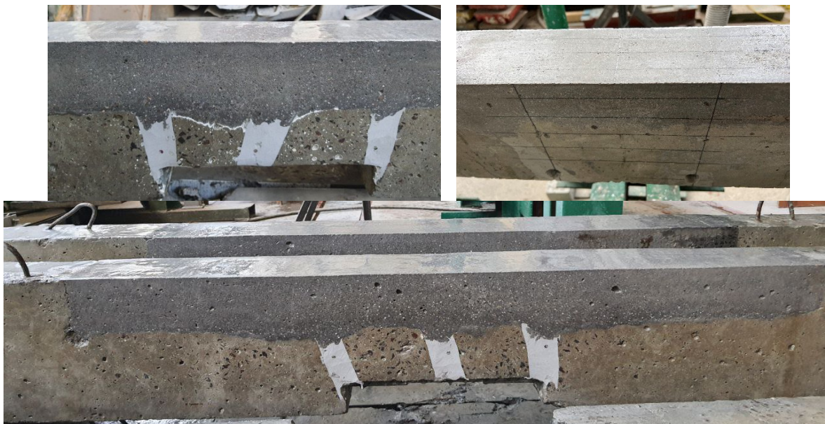
Рис. 2.41. Кінцевий вигляд відновленої залізобетонної балки методом ін'єктування епоксидною рідиною та відновлення стиснутої зони бетону
