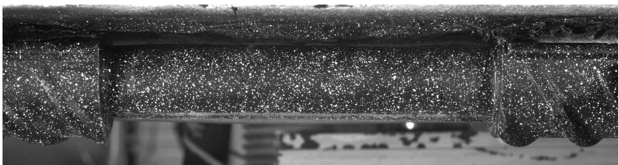
Рис. 2.52. Нанесені спекли на арматуру
