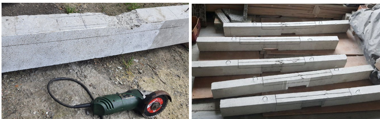
Рис. 2.13. Зрізання кутовою шліфувальною машиною ділянки бетону
