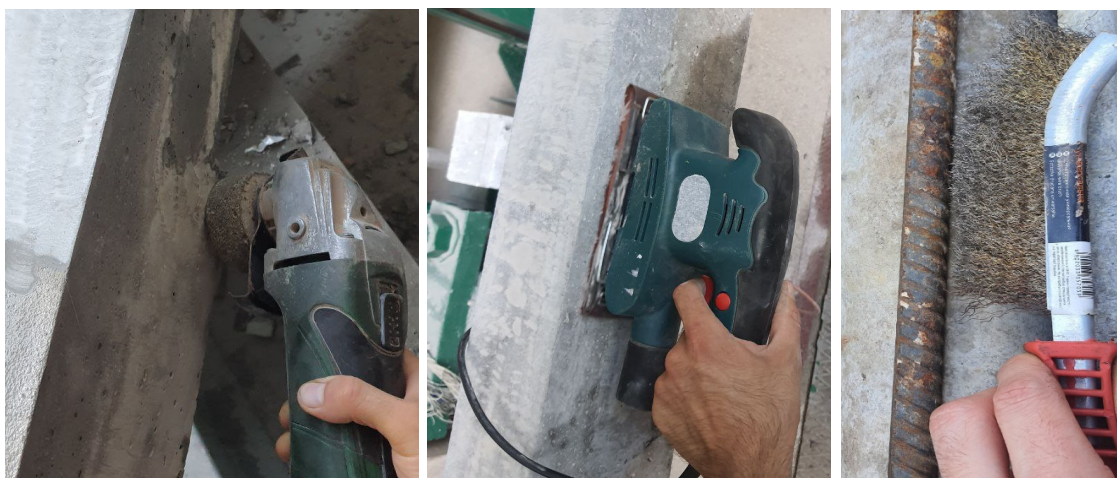
Рис. 2.47. Процес вирівнювання та зачистки поверхні бетону і арматури
