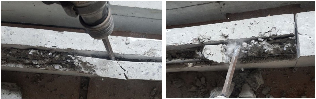
Рис. 2.14. Збивання бетону перфоратором
