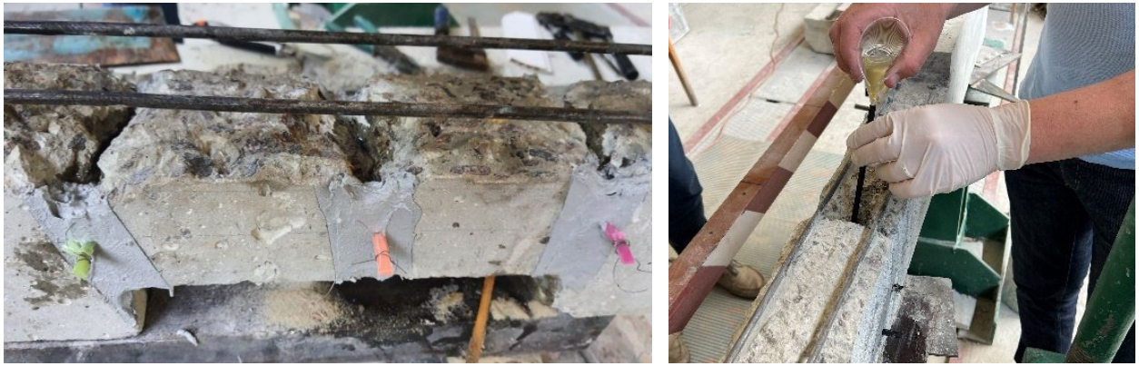
Рис. 2.40. Заливання Sikadur-52 Injection N
