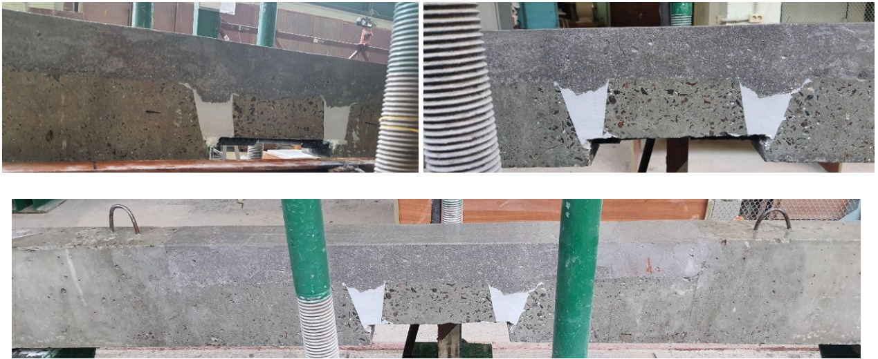
Рис. 2.28. Загальний вигляд залізобетонної балки після відновлення методом склеювання та відновлення стиснутої зони бетону
