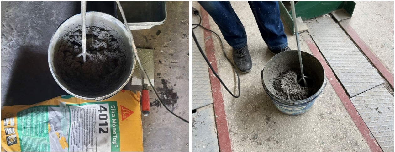
Рис. 2.17. Замішування розчину Sika MonoTop-4012
