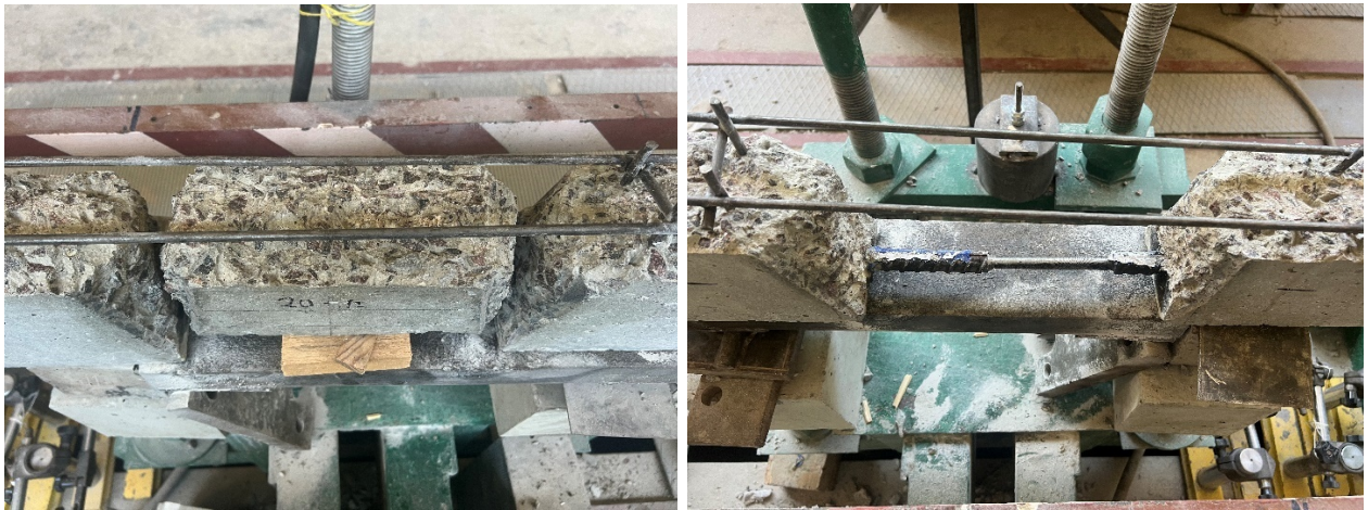
Рис. 2.21. Вигляд зруйнованої ділянки залізобетонної балки
