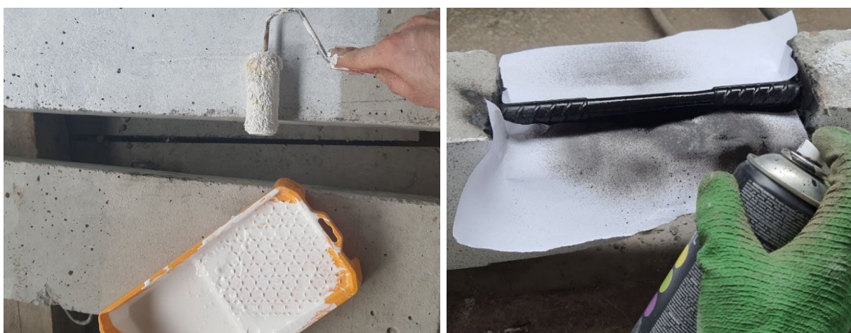
Рис. 2.48. Нанесення білого фону на бетон (зліва) і чорного фону на арматуру (справа)
