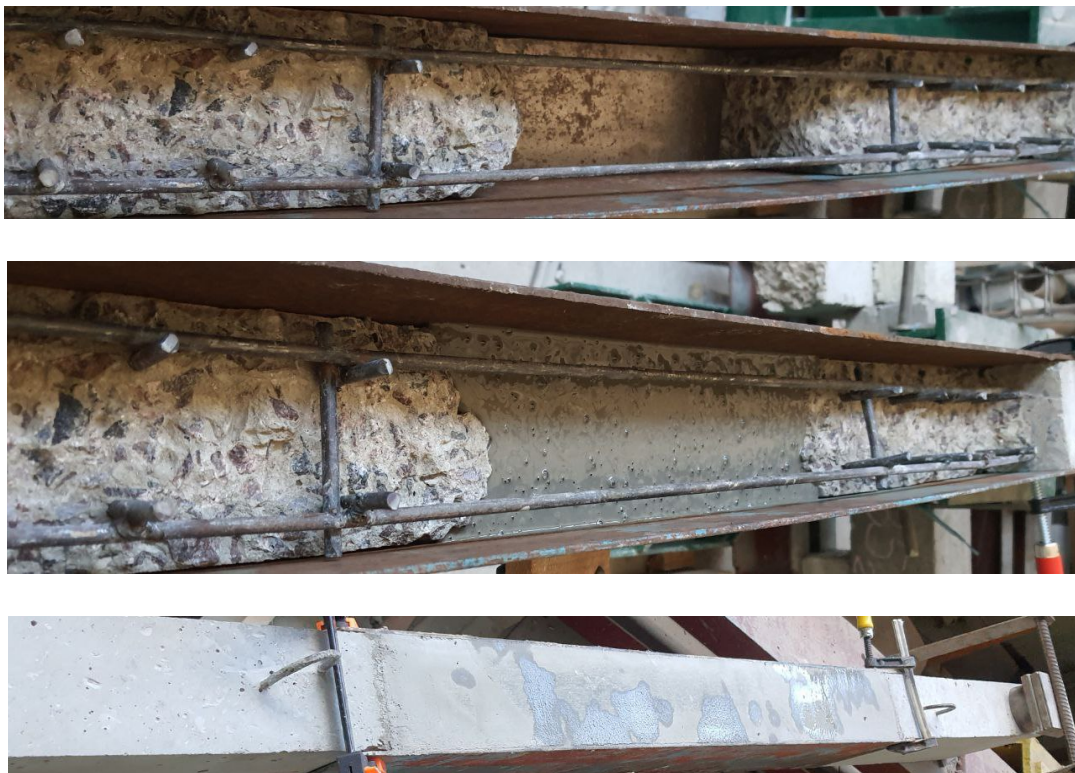
Рис. 2.31. Послідовне бетонування пошкоджених ділянок балок
