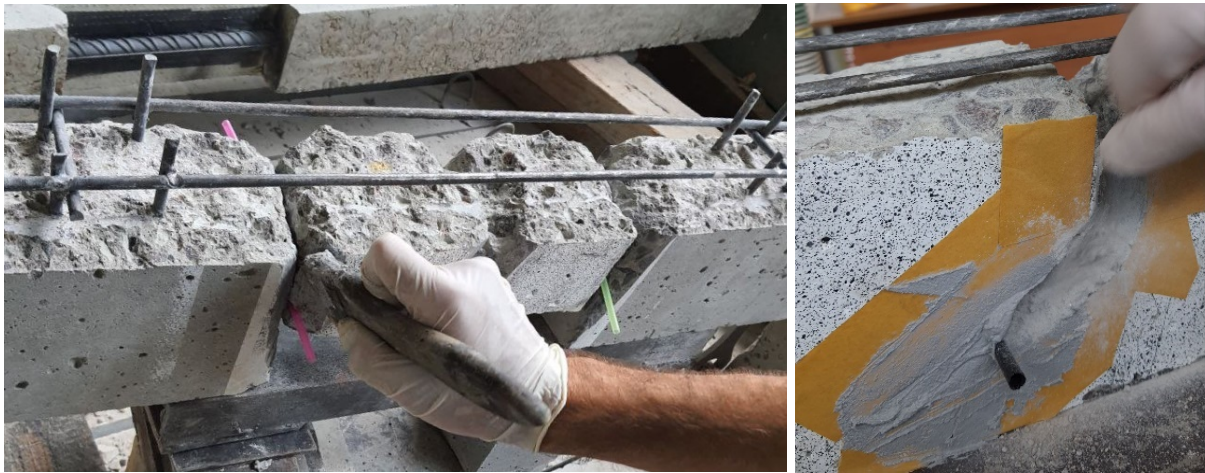
Рис. 2.37. Ґрунтування та кварцування поверхні
