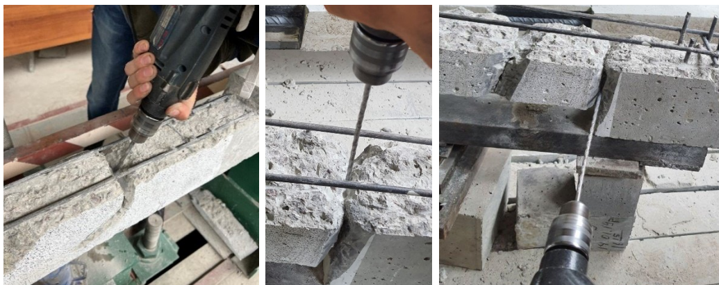
Рис. 2.34. Свердління отворів та підготовка поверхні до ін'єктування
