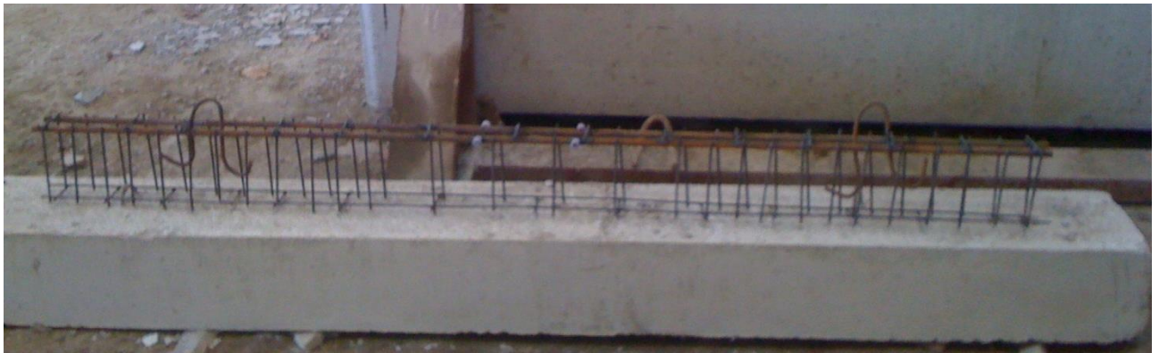
Рис.2.2. Загальний вигляд каркасу балок
