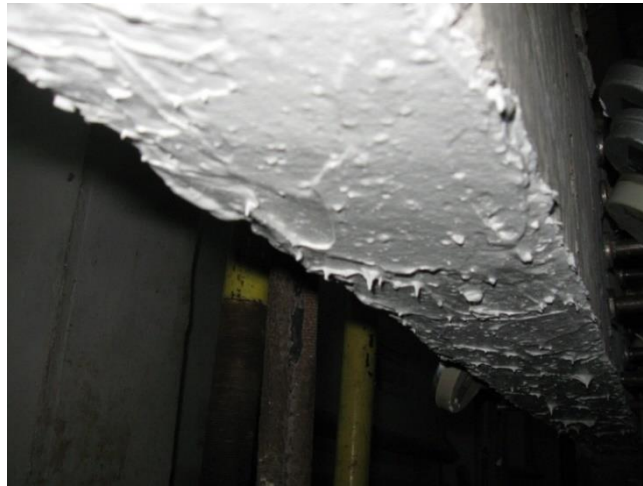
Рис. 2.10. Нанесення розчину Ruredil M750 на поверхню дослідних залізобетонних балок
