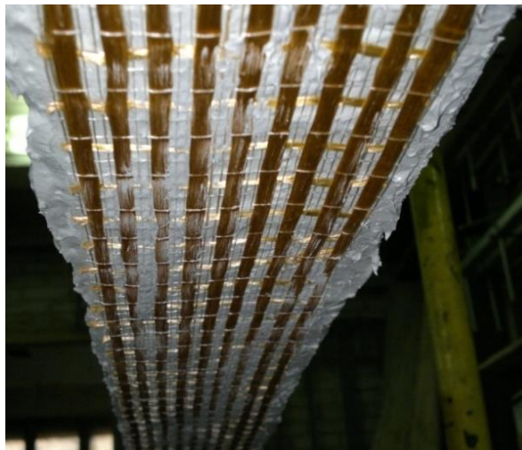
Рис. 2.11. Приклеювання одного шару сітки Ruredil X Mesh Gold шириною 10 см (9 пучків волокон) на поверхню дослідних залізобетонних балок
