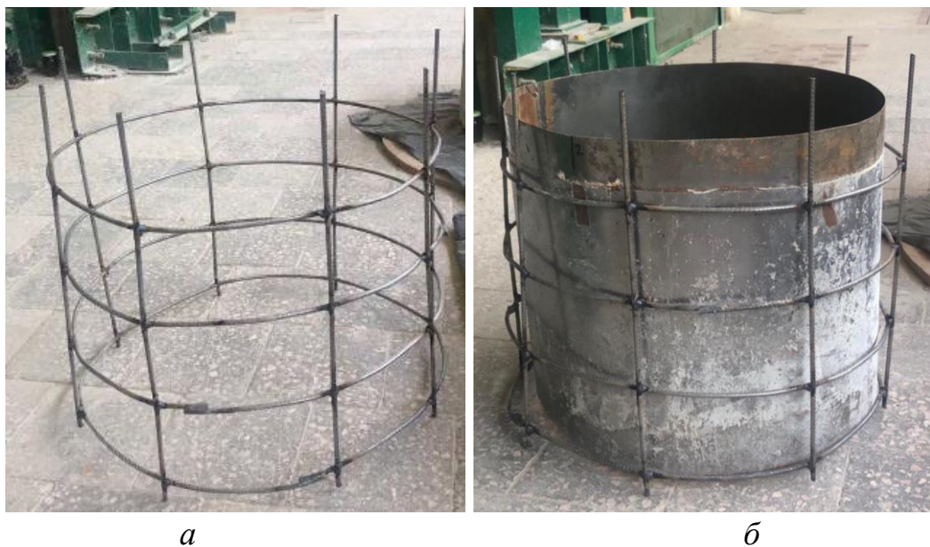
Рис. 4.16. Підсилення арматурним каркасом: а – арматурний каркас для зміцнення залізобетонної труби; б – розміщена всередині каркасу металева труба
