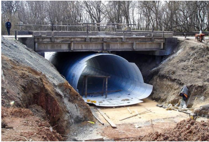
Рис. 2.5. Реконструкція переходу на автомобільній дорозі
