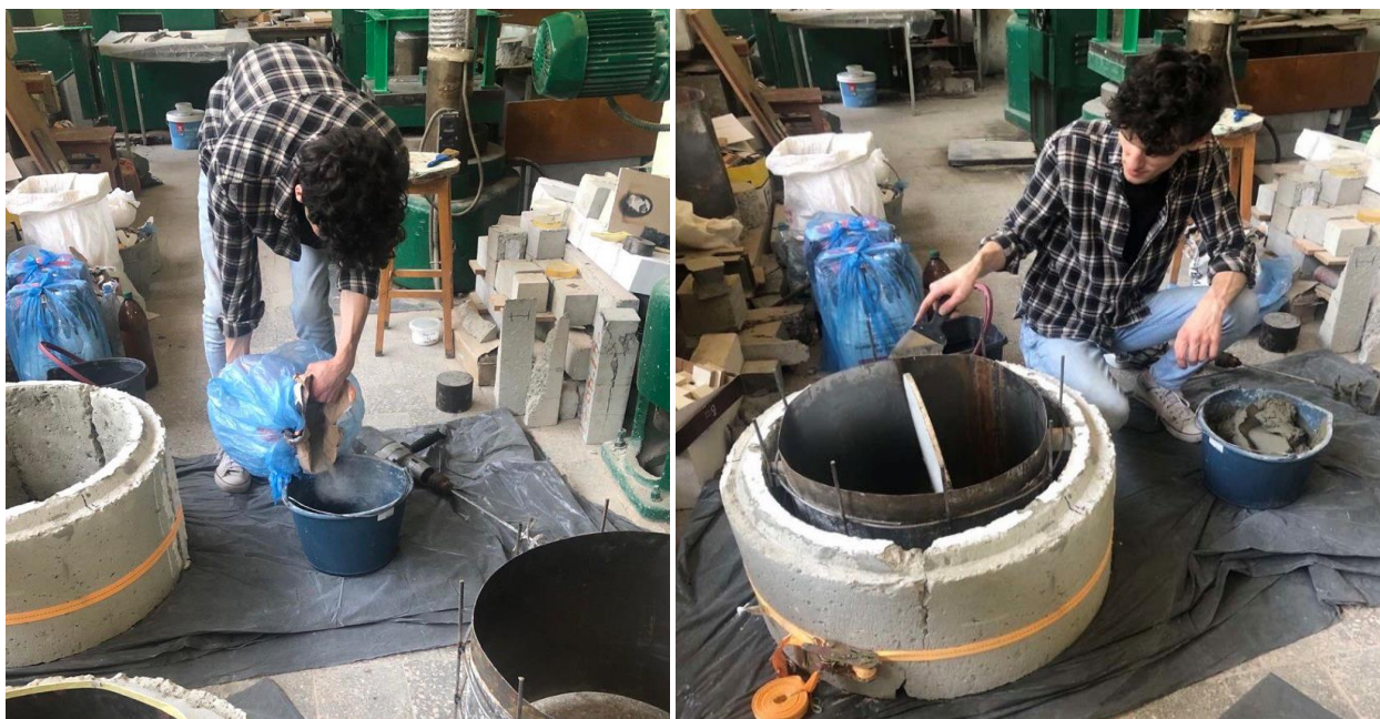
Рис. 4.18. Заповнення простору між трубами ремонтною сумішшю: а – замішування сухої будівельної суміші; б – заповнення міжтрубного простору сумішшю
