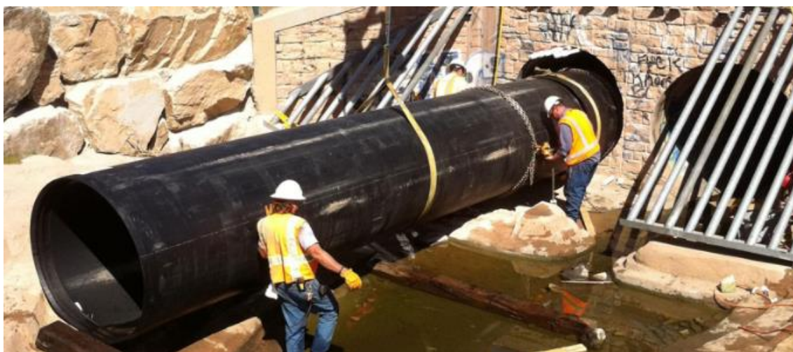
Рис. 1.15. Відновлення труби методом гільзування із використанням поліетиленової труби високої щільності [119]
