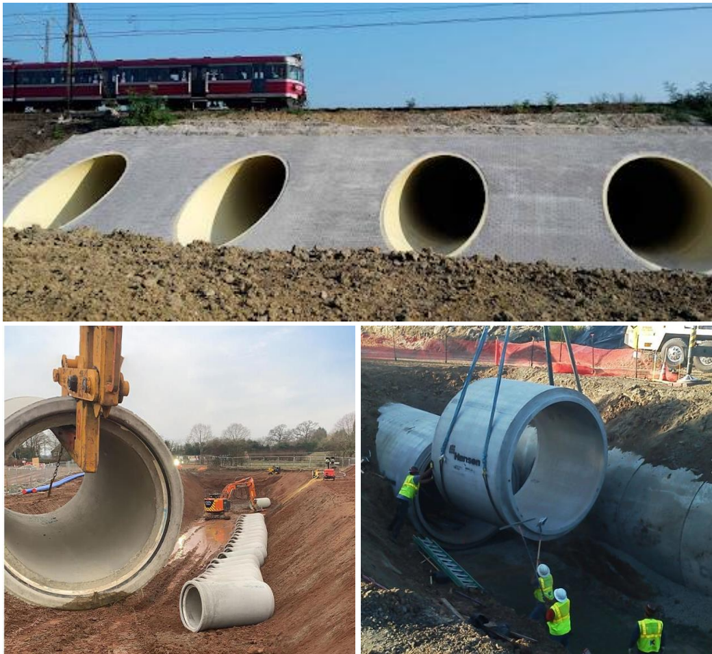
Рис. 1.1. Водопропускні залізобетонні труби [5]
