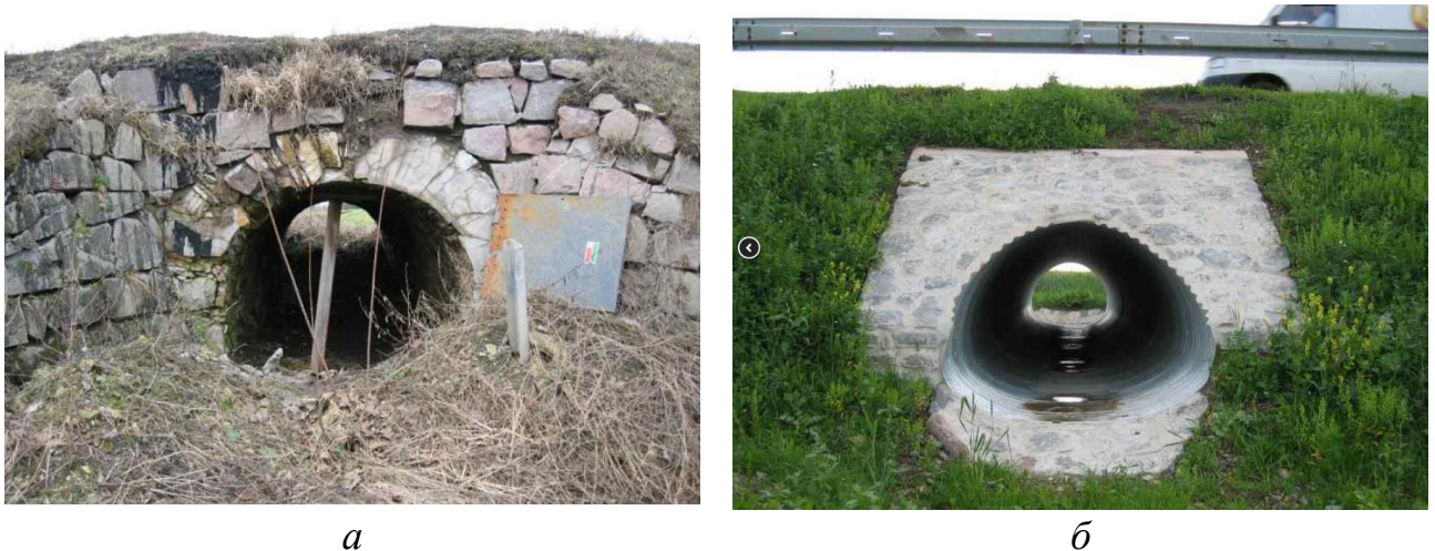
Рис. 2.2. Ремонт водопропускної труби методом гільзування в м. Жамберк, Чехія [129]: а – до ремонту; б – після ремонту
