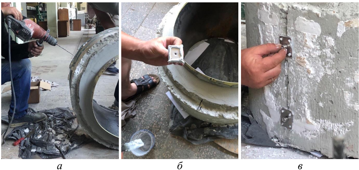
Рис. 4.20. Встановлення пакерів на поверхні тріщини: а – виконання отворів; б – нанесення епоксидної пасти на пакер; в – закріплення пакеру на поверхні тріщини
