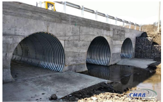
Рис. 2.6. Ремонт мосту через річку Коритна на км 15+372 автомобільної дороги загального користування місцевого значення О-02-27-03 Качківка-Дзигівка-Михайлівка у Вінницькій області [132]: а – до ремонту; б – після ремонту
