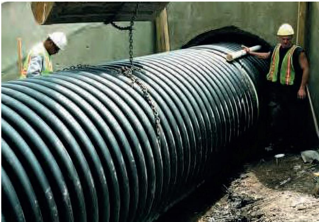
Рис. 2.4. Відрновлення залізобетонної водопропускної труби методом гільзування в м. Вілмінгтон, штат Делавер (США) [131]
