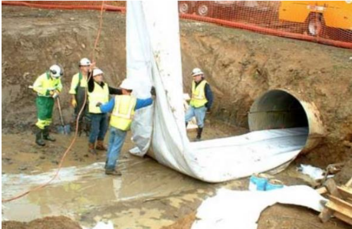
Рис. 1.16. Процес відновлення труби методом «відновлення на місці» [121]
