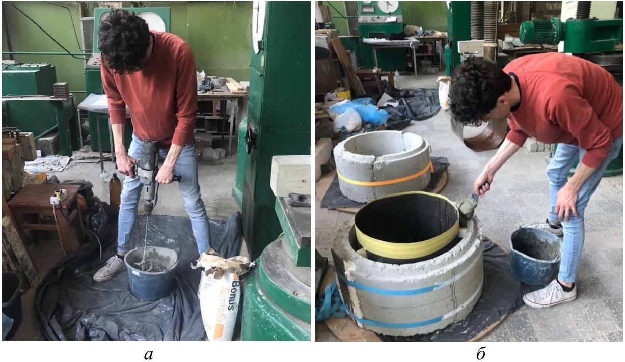
Рис. 4.14. Заповнення простору між трубами ремонтною сумішшю: а – замішування сухої будівельної суміші; б – вкладання суміші в конструктивний зазор
