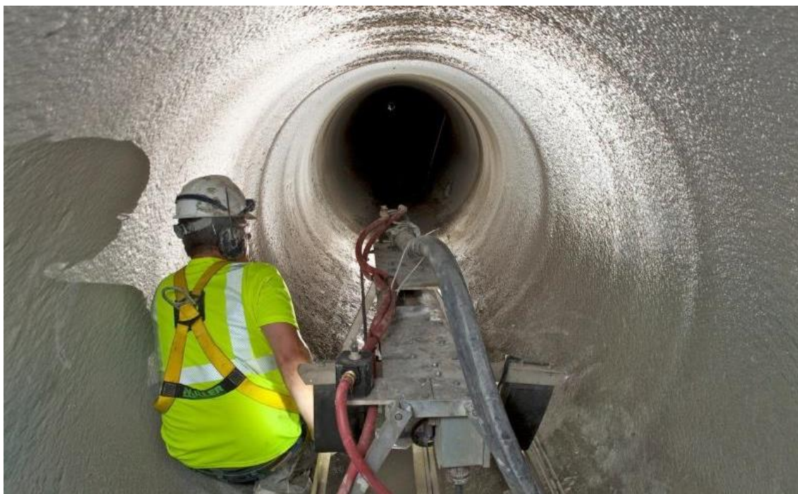
Рис. 1.17. Відновлення верхнього шару труби шляхом нанесення покриття [123]
