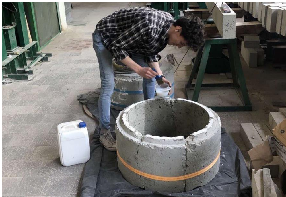
Рис. 4.11. Ґрунтування внутрішньої поверхні пошкодженої залізобетонної труби
