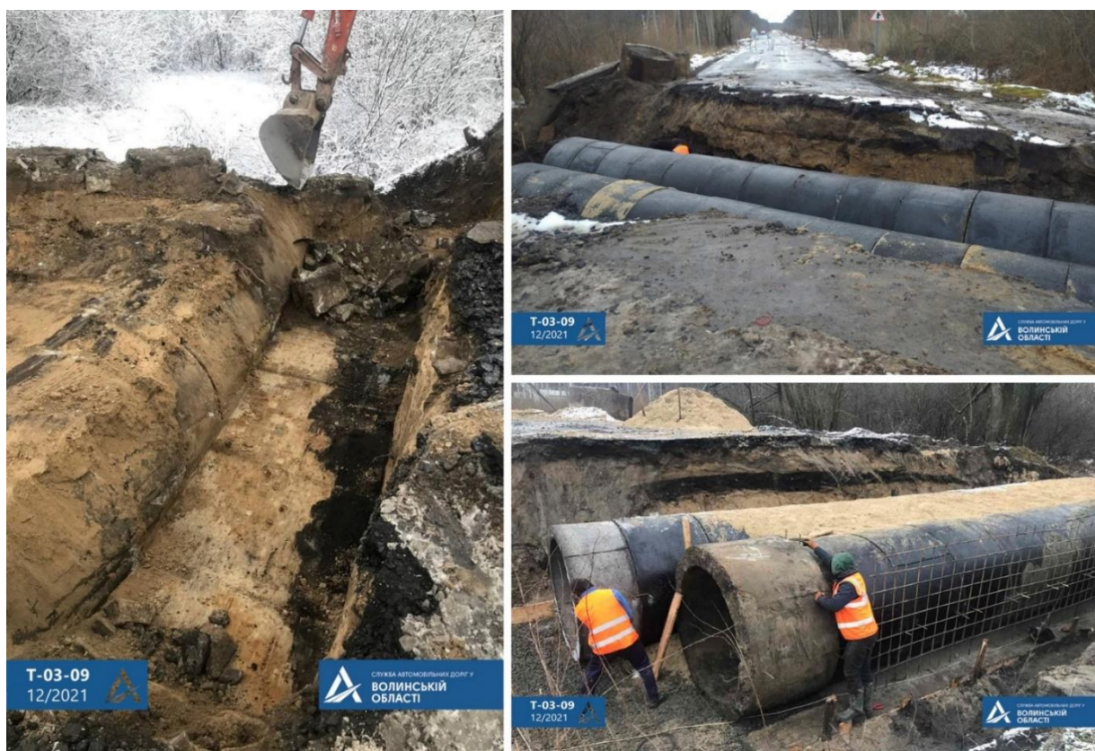
Рис. 1.13. Заміна водопропускної труби у м. Ківерці на автомобільній дорозі Т-03-09 Дубечне–Стара Виживка–Турійськ–Рожище–Ківерці–Піддубці [116]
