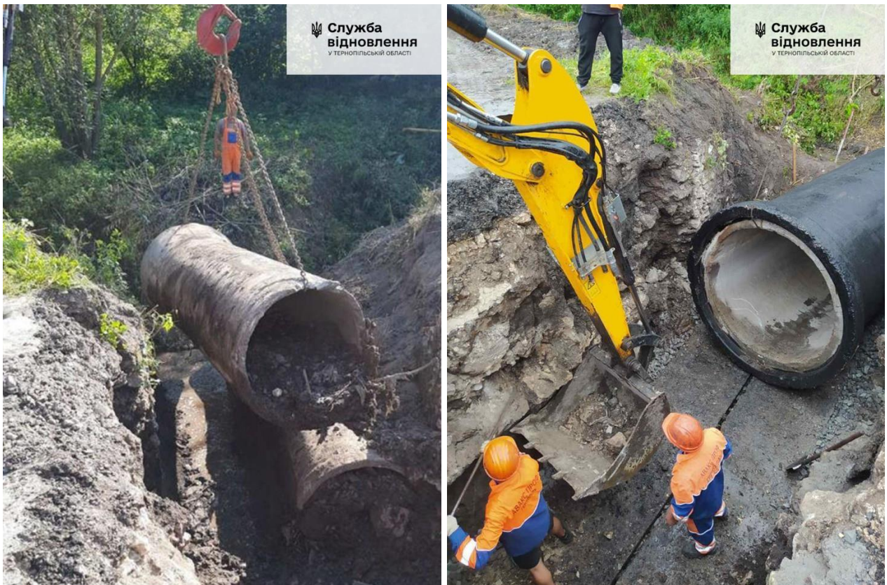
Рис. 1.14. Заміна водопропускних труб у с. Лопушне, на автомобільній дорозі Т-20-13 [116]
