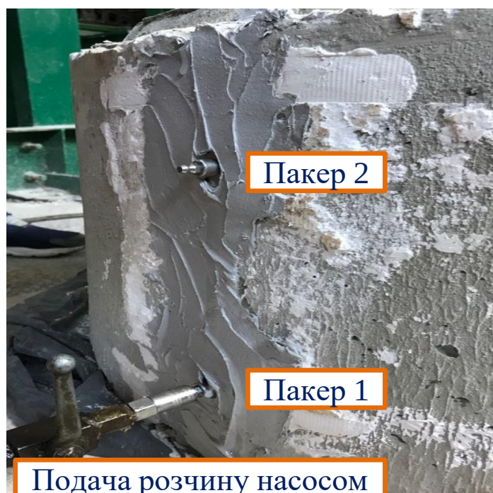
Рис. 4.25. Процес ін'єктування тріщин розчином
