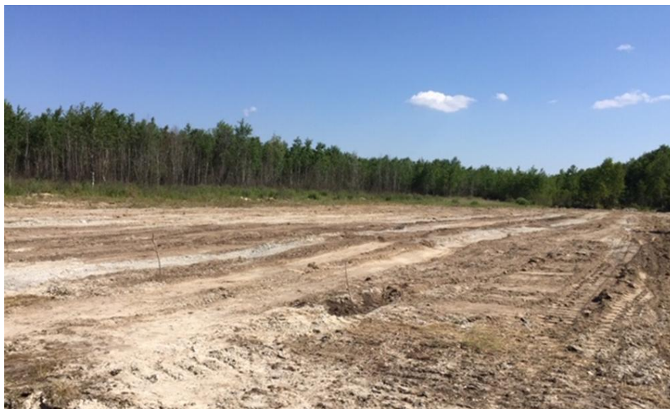
Рисунок 5.2. – Результати вирівнювання поверхні та засипання провалів частини території хвостосховища
