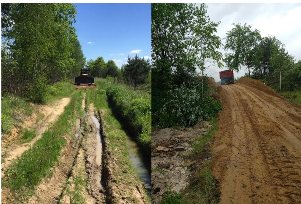
Рисунок 5.1. - Облаштування дороги через дамбу хвостосховища для можливості проїзду інженерної техніки до місця проведення робіт: а – початкова стадія роботи техніки, б – проїзд інженерної техніки
