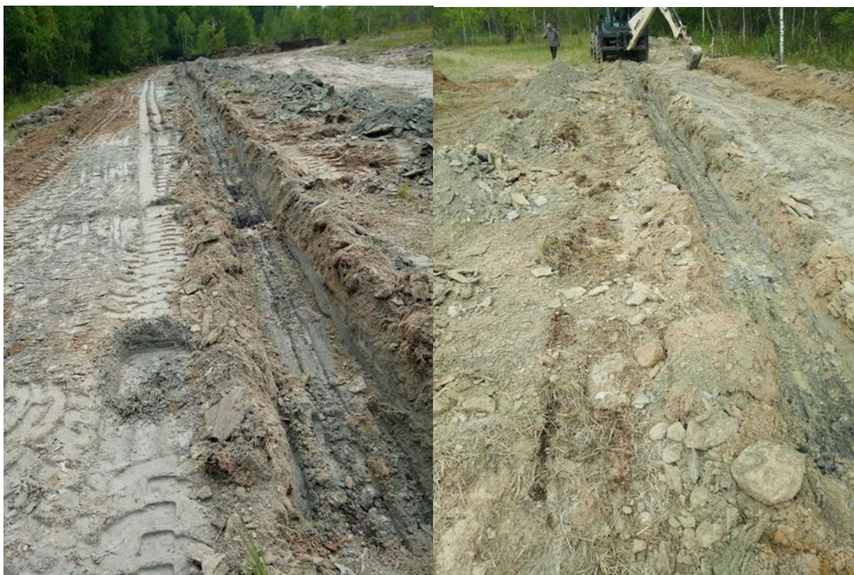
Рисунок 5.3. – Облаштування заглибин для створення необхідної товщини шару ґрунту у місці висаджування дерев
