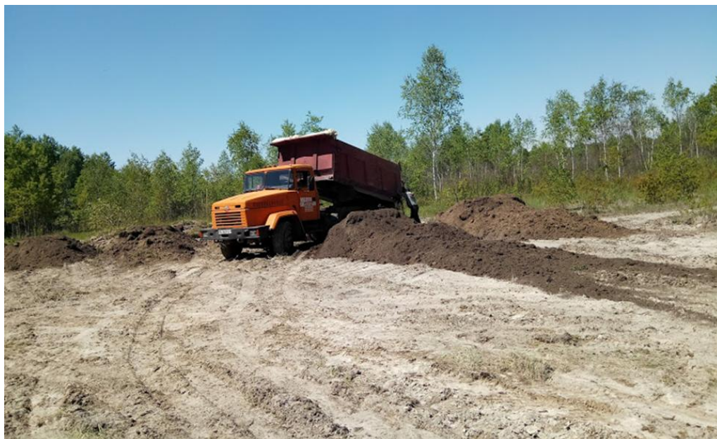
5.4.- Покриття поверхні рекультивації родючим шаром ґрунту
