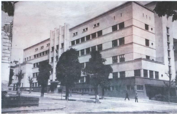
Рис. 2.3.5. Гуртожиток підмайстрів (бурса) імені Іона Ністора в Чернівцях. 1934-36 рр. Арх. Леон Сіліон. (Зображення– Artdeco-modernist, 2011)
