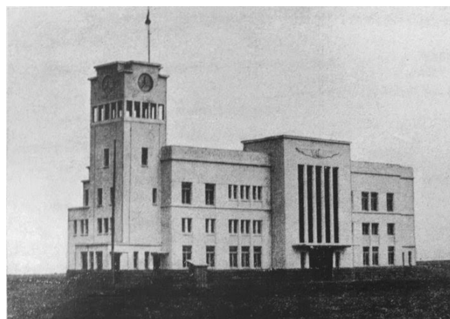
Аеропорт імені короля Кароля II в Чернівцях. 1933-1937 рр. Арх. Константін Драгу. (Aerogară, Cernăuți, 2016)
