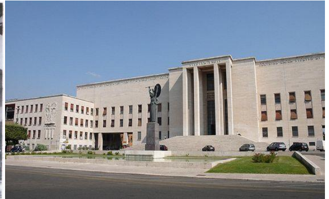
Рис. 2.3.6. Будівля головного корпусу Міського університету La Sapienza в Римі. 1930-ті рр. Арх. Марчелло П'ячентіні. (Зображення– Ilmessaggero, 2010)
