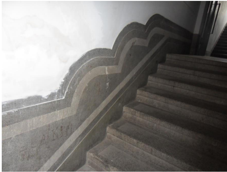
Рис. 3.3.4. Будинок по вул. Сімовича, 5 (Фото автора)
