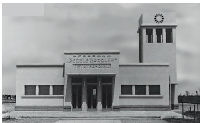
Рис. 2.2.6а. Аеропорт імені короля Кароля II в Четалея-Албі (Білгород-Дністровський). 1935–39 рр. Арх. Константін Драгу. (Історія аеропорта Четатя-Албэ/Аккерман, 2016)
