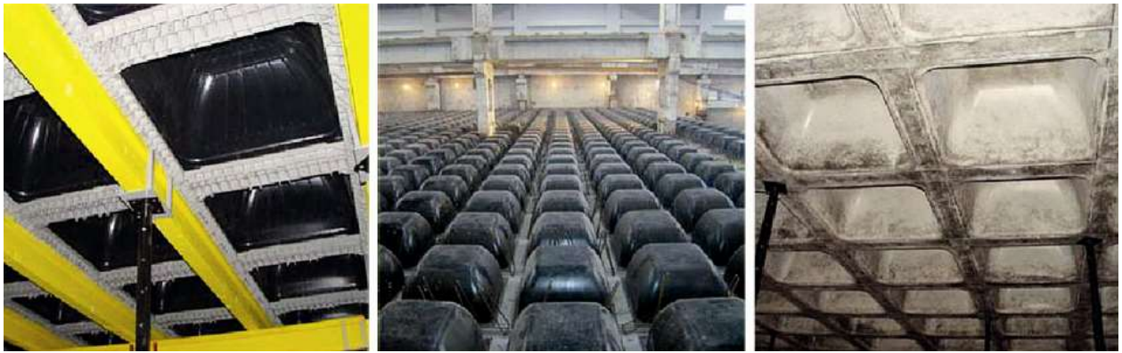
Рис. 1.4. Загальний вигляд монолітного кесонного перекриття під час виготовлення з використанням пластмасових порожнино-утворювачів
