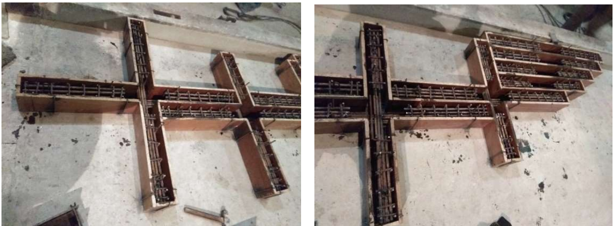
Рис. 2.7. Влаштування опалубки та армування дослідних зразків
