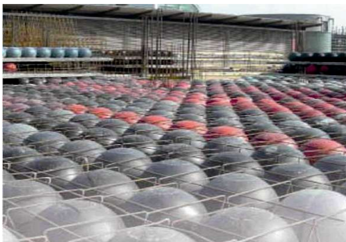
Рис. 1.7. Загальний вигляд на улаштування перекриття зі вставками сферичної форми системи COBIAХ
