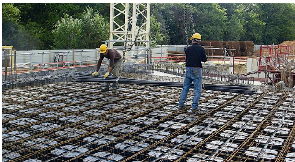
Рис. 1.8. Загальний вигляд на улаштування перекриття з вставками систем U-boot
