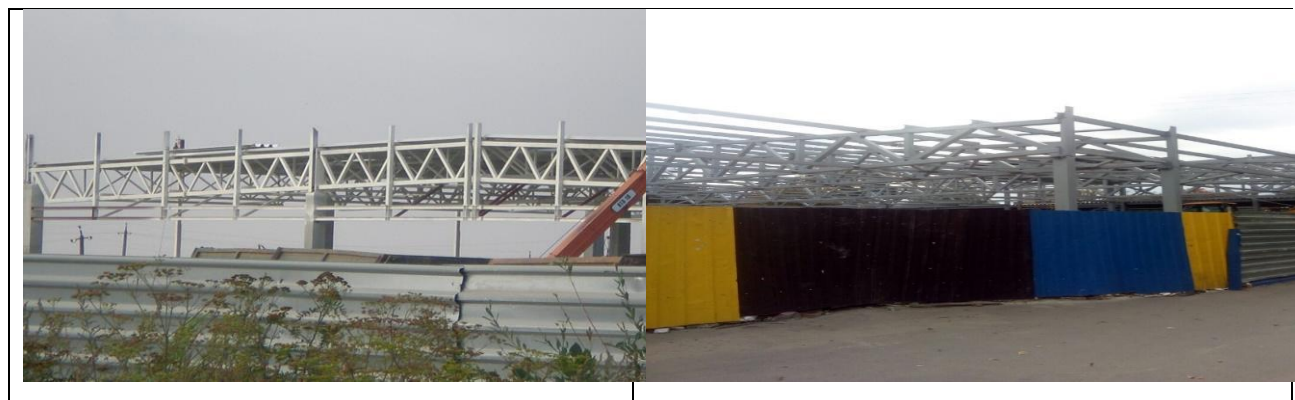
Рис. 1.1. Сталеві фермові конструкції покриття: а - Львів, будівництво торгового центру “Ашан”; б - Львів, будівництво супермаркету “АТБ”
