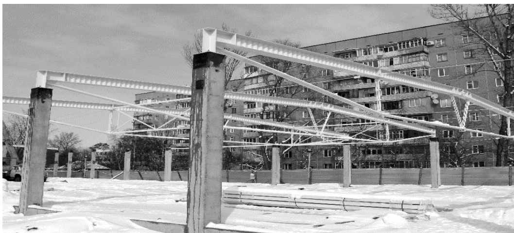
Рис. 1.3. Малоелементна шпренгельна ферма, Київ
