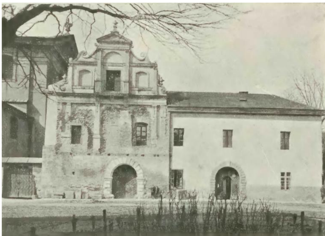
Додаток 19. Фасад Королівського арсеналу у процесі реставрації. 1930-ті рр. 1083
