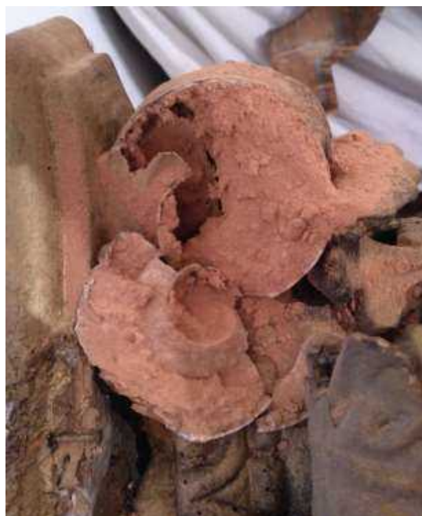
Рис. 2.6. Знищена волюта капітелі початку ХХ століття з слідами життєдіяльності жуків-точильників. (Фото автора).
