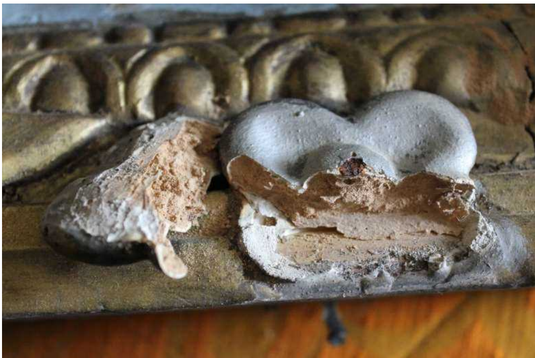
Рис. 3.3. Сильно ушкоджений шкідниками елемент капітелі. (Фото автора).
