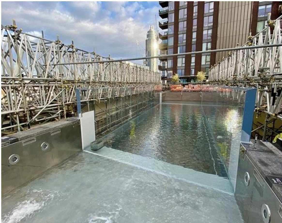
Рис.1.12. Кострукції басейну «СкайПул» на етапі монтажу [106].
