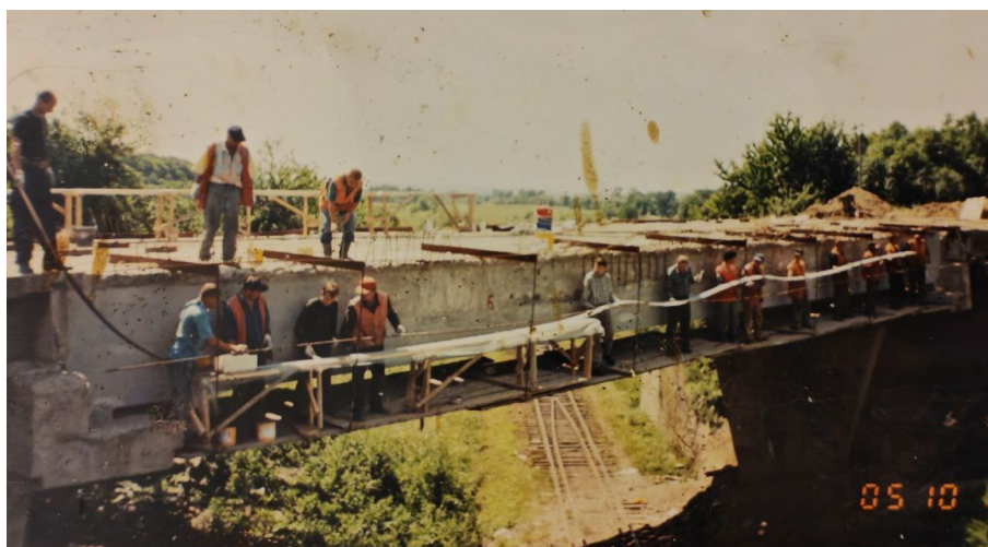
Рисунок 1.8 - Загальний вид шляхопроводу після реконструкції (а); наклеювання стрічки підсилення (б).
