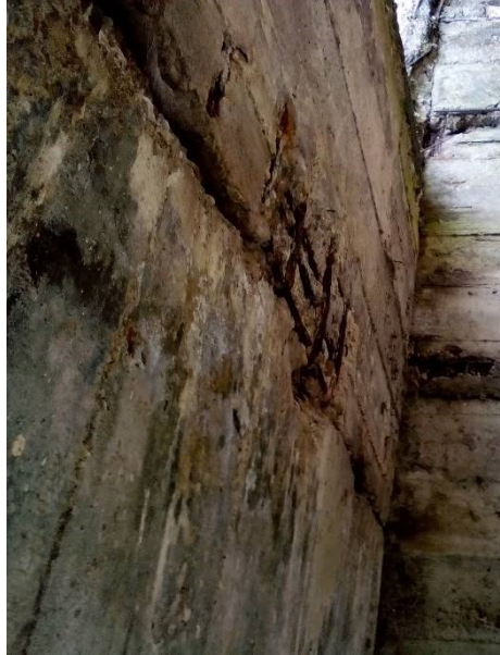
Рисунок 5.12 - Характерні дефекти залізобетонних конструкцій моста. а - руйнування крайніх монолітних плит прольотної будови; б – нахилування відкосного крила; в – ділянки відшарування захисного шару і відкриття арматури збірних плит прольотної будови; г – неякісно замонолічені поздовжні шви між плитами та задовільний
