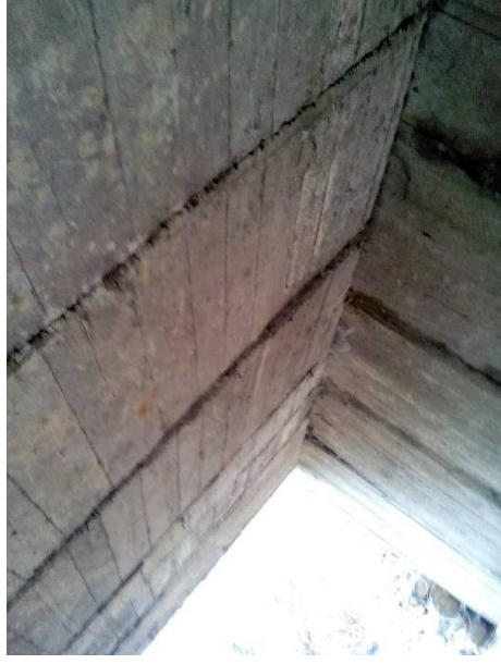
Рисунок 5.12 - Характерні дефекти залізобетонних конструкцій моста. а - руйнування крайніх монолітних плит прольотної будови; б – нахилування відкосного крила; в – ділянки відшарування захисного шару і відкриття арматури збірних плит прольотної будови; г – неякісно замонолічені поздовжні шви між плитами та задовільний
