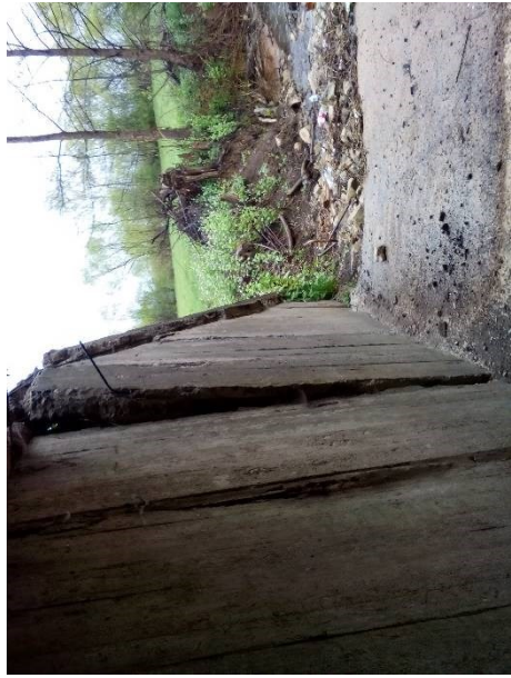
Рисунок 5.12 - Характерні дефекти залізобетонних конструкцій моста. а - руйнування крайніх монолітних плит прольотної будови; б – нахилування відкосного крила; в – ділянки відшарування захисного шару і відкриття арматури збірних плит прольотної будови; г – неякісно замонолічені поздовжні шви між плитами та задовільний
