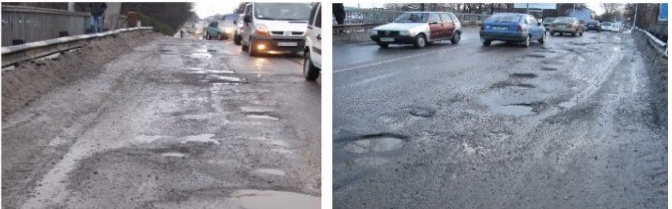
Рисунок 5.4 - Загальний вид існуючого шляхопроводу (а) та вид на мостове полотно (б)
