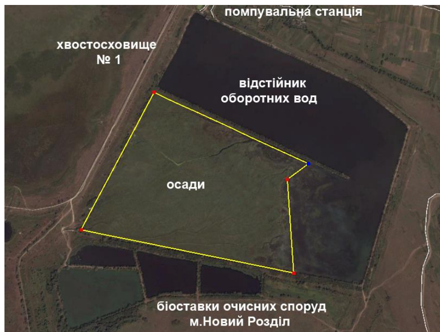
Рис. 2.9. Розташування відстійників оборотних вод осадів та будівлі помпувальної станції на космоснімку.
