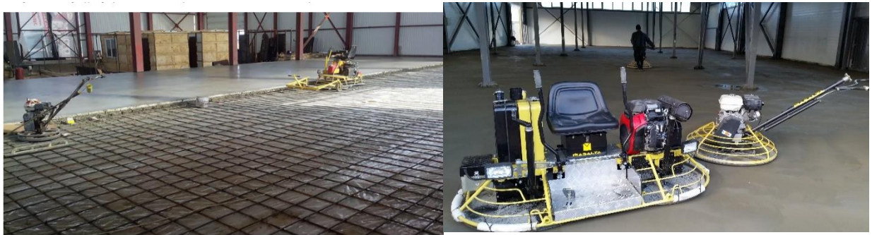
Рисунок 5.3 – Основні технологічні операції з влаштування промислової підлоги: армувальні роботи та заливка бетону (а), затирання поверхні (б)
