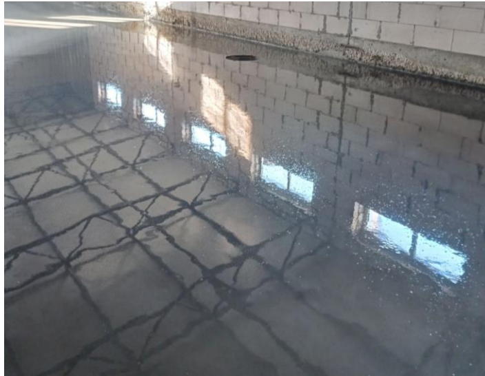
Рисунок 5.5 – Влаштування бетонної підлоги у складському приміщенні ТзОВ «Гартекс»
