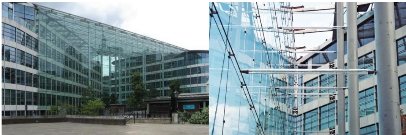
а) б) Рис. 1.8 Загальний вигляд «Tower Place»: а) фасаду [139]; б) «скляні голки» [132].
