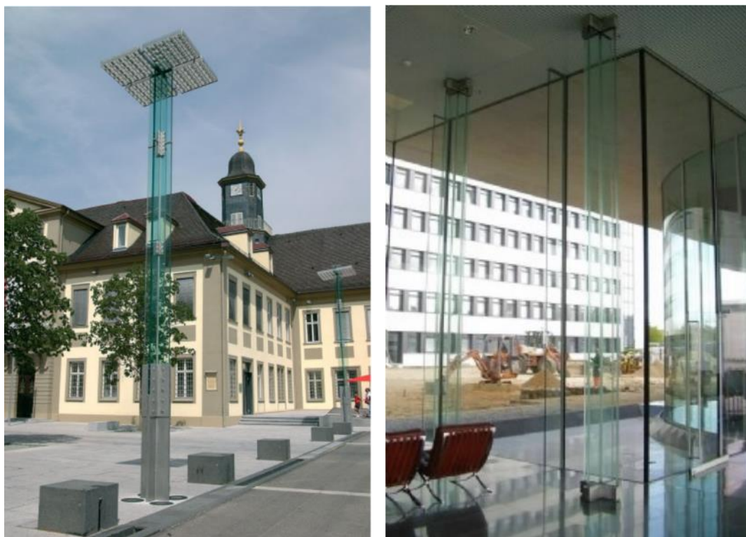
Рис. 1.6 Зображення реалізованих скляних колон: а) опори ліхтарів на площі Ринок в Геппінгені [118]; б) штаб-квартира «Danfoss» в Нордборзі [123].
