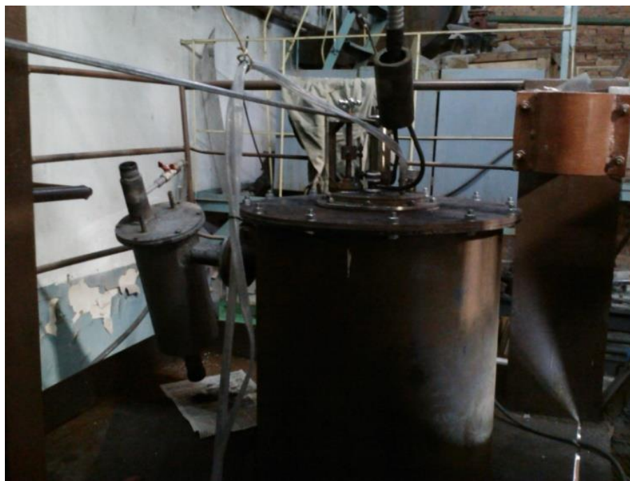
Рис. 4.26. Зовнішній вигляд реактору лабораторної установки для процесу високотемпературного піролізу вуглеводневих газів
