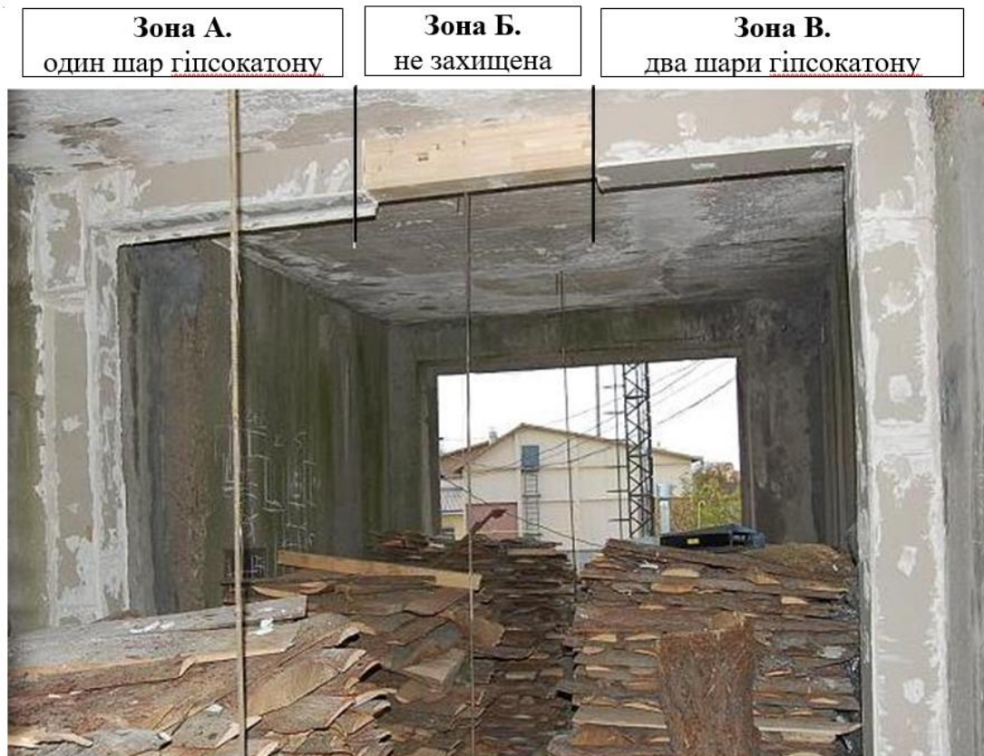
Рис. 2.12. Конструкція рами підготовлена до випробувань в приміщенні з встановленим пожежним навантаженням
