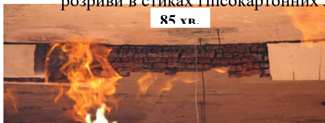
в) Обвуглювання балки на глибину 60 – 70 мм в зоні Б, відпадання двох шарів гіпсокартону від конструкції
