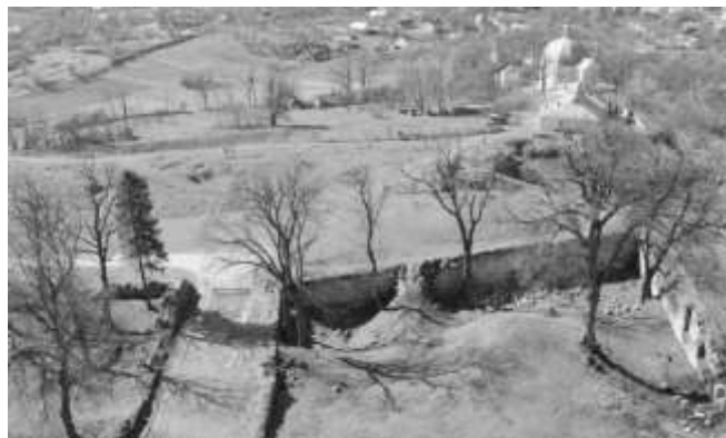
Рис. 11. Фіксація стану збереження оборонних споруд монастиря оо. Домініканів у Підкамені. Вигляд на в'їздний оборонний вузол з вежі костелу (світлина авт. 2014 р.)
