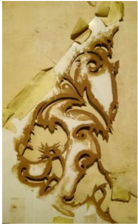
Рис. 15. Один із способів перенесення малюнка на поверхню склепіння, нанесення фарби за трафаретом.
