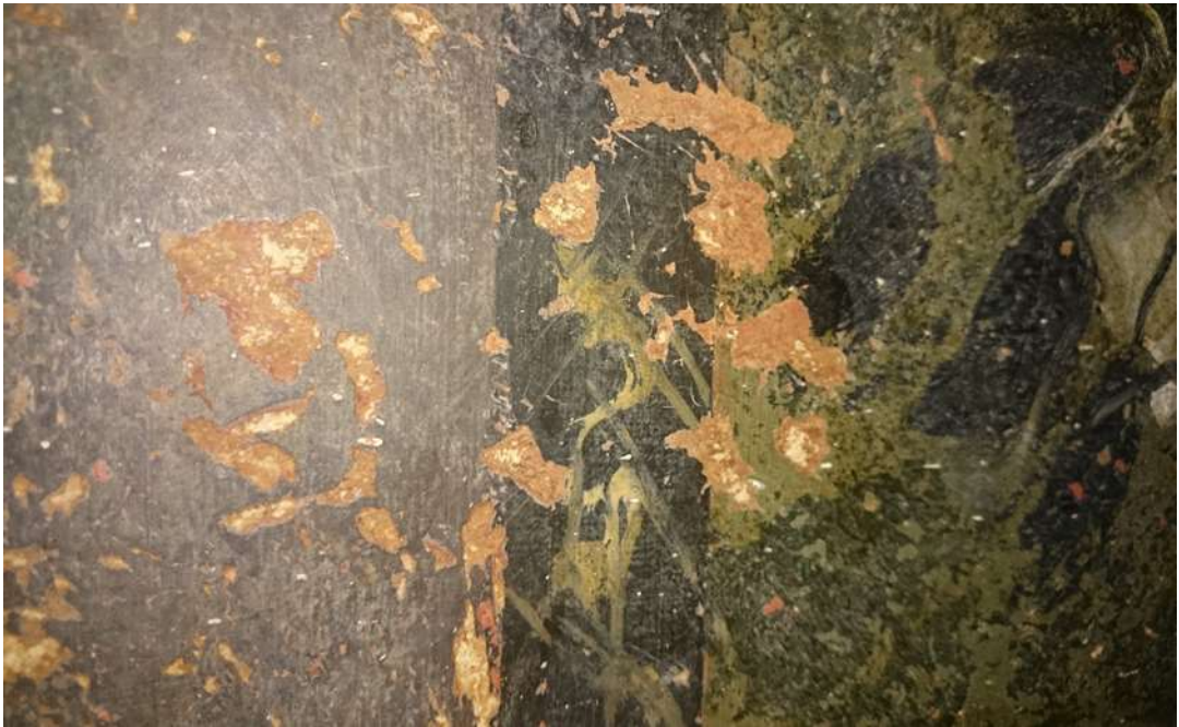
Рис. 11. Типовий характер пошкоджень автентичного малярського шару на всіх поверхнях стін. Фото С.Гетьманчук.
