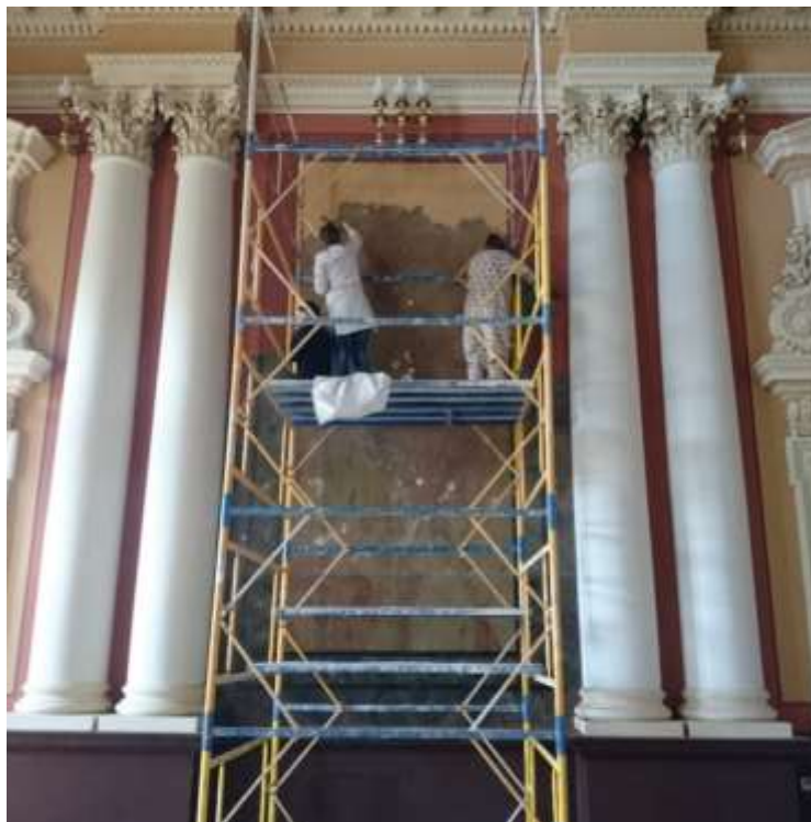
Рис. 12. Фото західної стіни актової зали у процесі розчищення від нашарувань фарби до автентичного шару мармуризації. Фото С.Гетьманчука. Стан збереження автентичного шару у цьому простінку був одним з найкращих.
