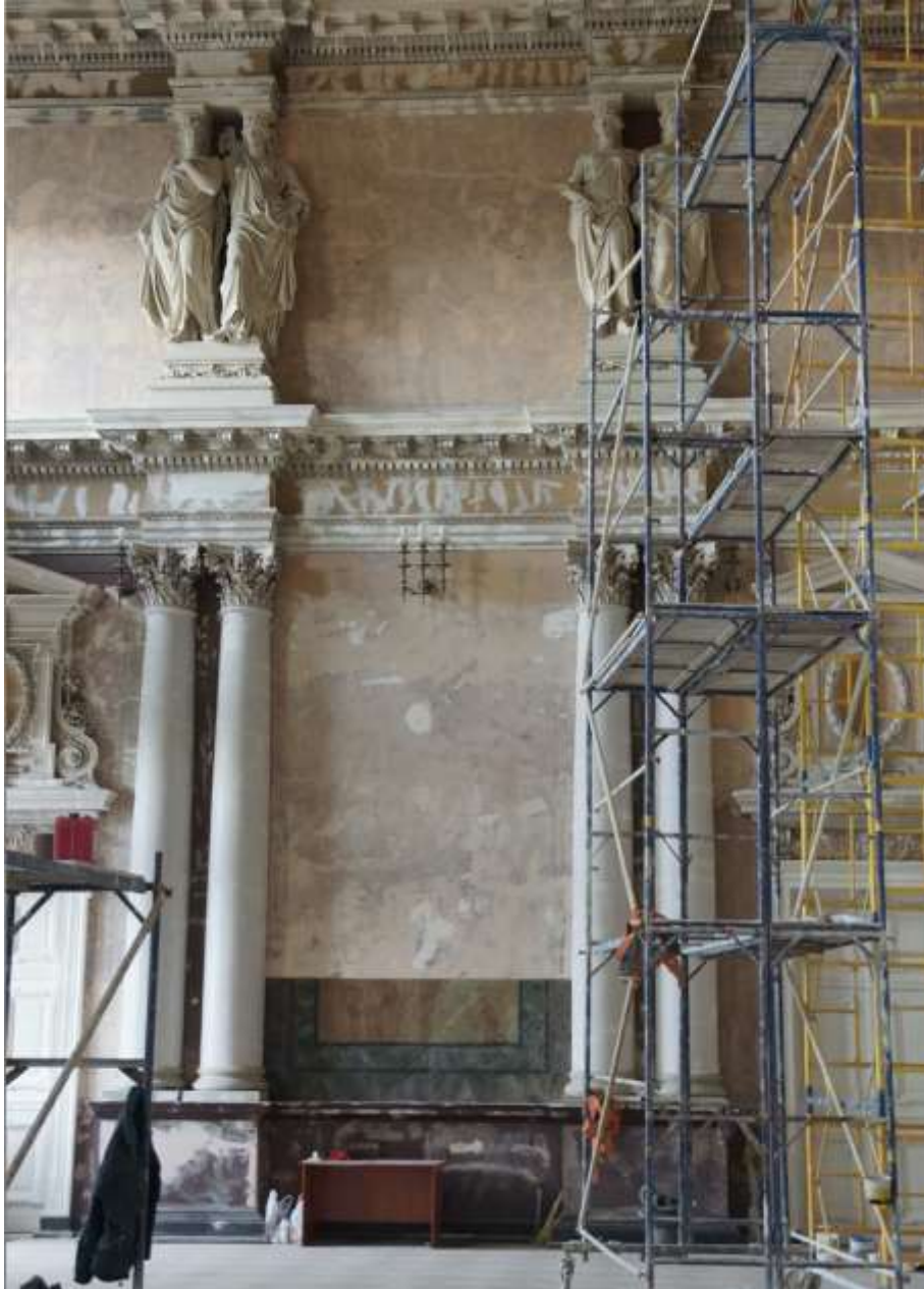
Рис. 10. Фото західної стіни актової зали у процесі ремонтних робіт 2014 р. з розкритою смугою автентичного малярського шару мармуризації у нижній частині. Фото М.Бевза.
