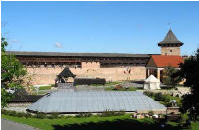
Рис.2. Загальний вигляд накриття експозиційного павільйону решток церкви Івана Богослова на дитинці замку в Луцьку (Лукомкьий, Петрик, 2003)
