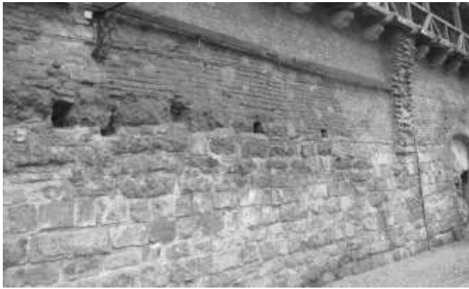
Рис. 12. Фіксація стану збереження оборонних споруд монастиря оо. Бернардинів у Львові. Внутрішній фасад оборонного муру. Виявлено чорна патина та відшарування каменю, деградація цегляного мурування. (світлина авт. 2016 р.)
