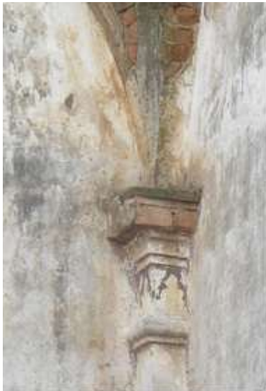
Фото 21. Підп'ятник втраченого склепіння у північно-східному куті молитовного залу.
