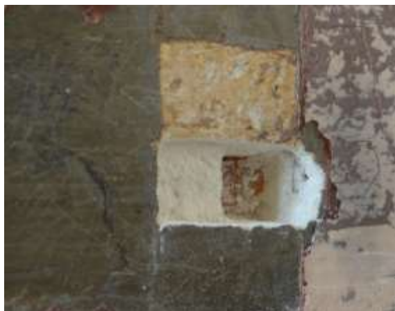
Рис. 6. Фотофіксація зондажу у фарбових покриттях та тиньку. Фото М.Бевза, 2015.
