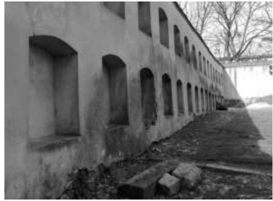
Рис. 13. Фіксація стану збереження оборонних споруд монастиря оо. Кармелітів босих у Львові. Виявлено заволодження муру та відшарування тиньку XIX ст. (світлина авт. 2018 р.)
