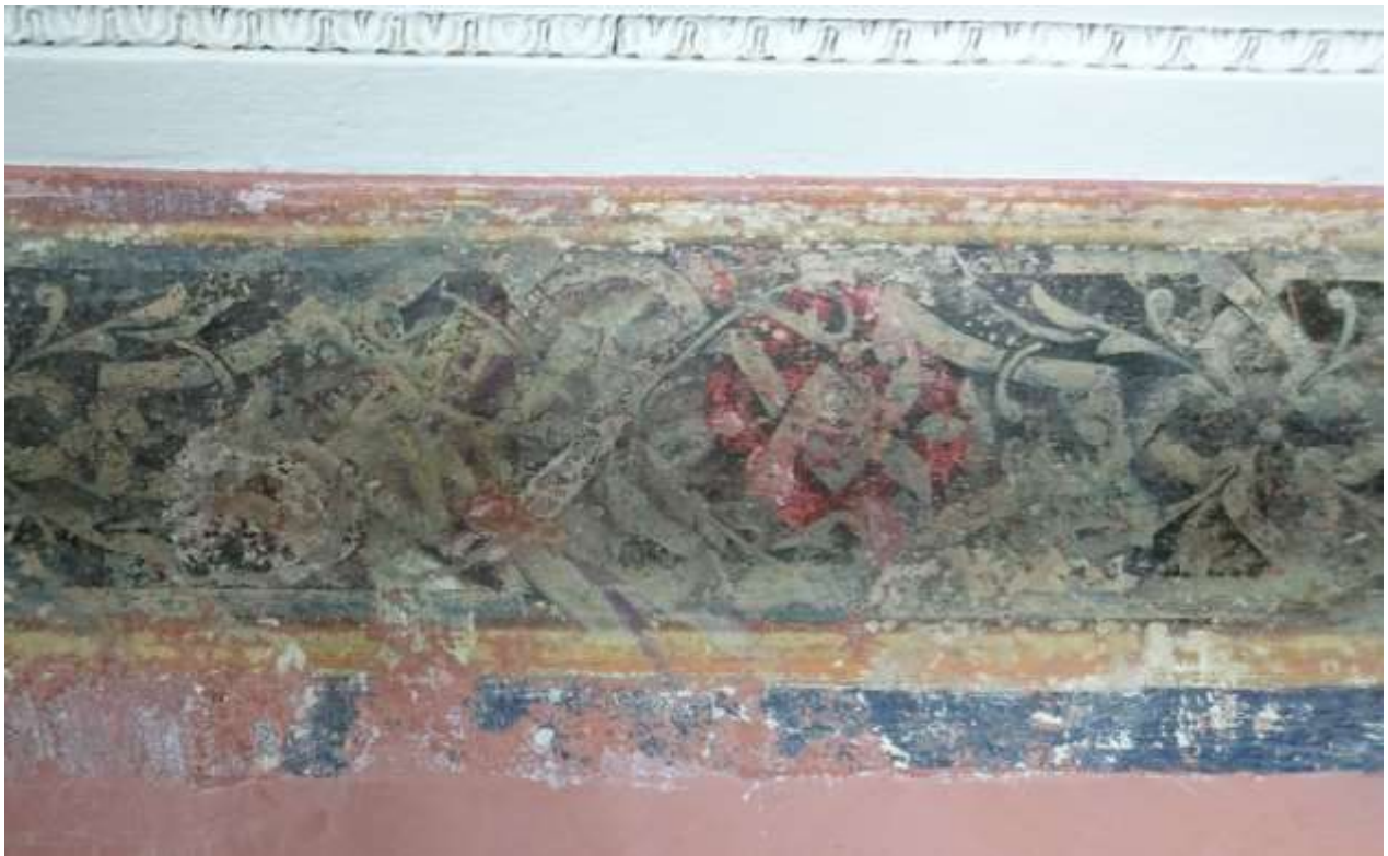
Рис. 8. Зондаж у фарбових покриттях фризу актової зали. Виявлено дві первісні малярські декорації: перша - з активною червоною кольористикою з квітуовим орнаментом; друга – накрила першу та має характер геометричного орнаментного поясу у жовто-охристій гамі (зондаж виконав С.Гетьманчук, фото М.Бевз).
