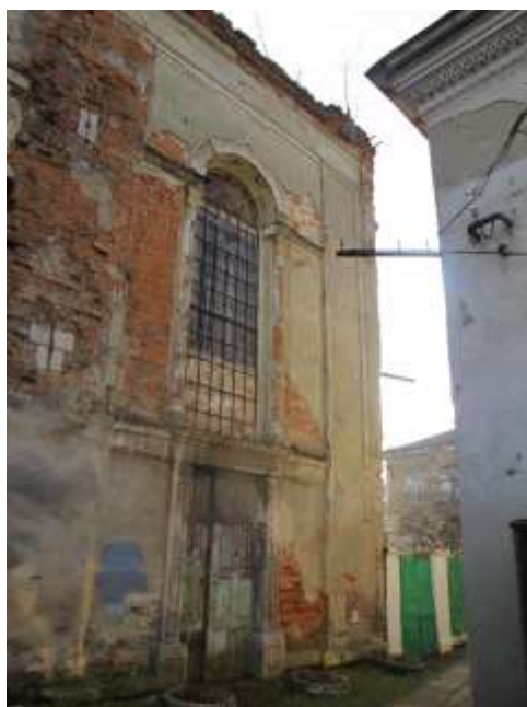
Рис. 18. Фрагмент північного фасаду з входом у західні синагогальні приміщення.
