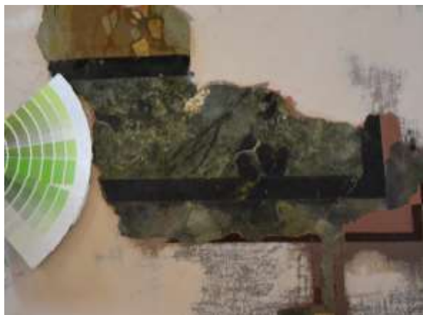
Рис. 7. Фотофіксація зондажу із злуцненнями та саморозкриттями фарбових шарів. Фото М.Бевза, 2015.
