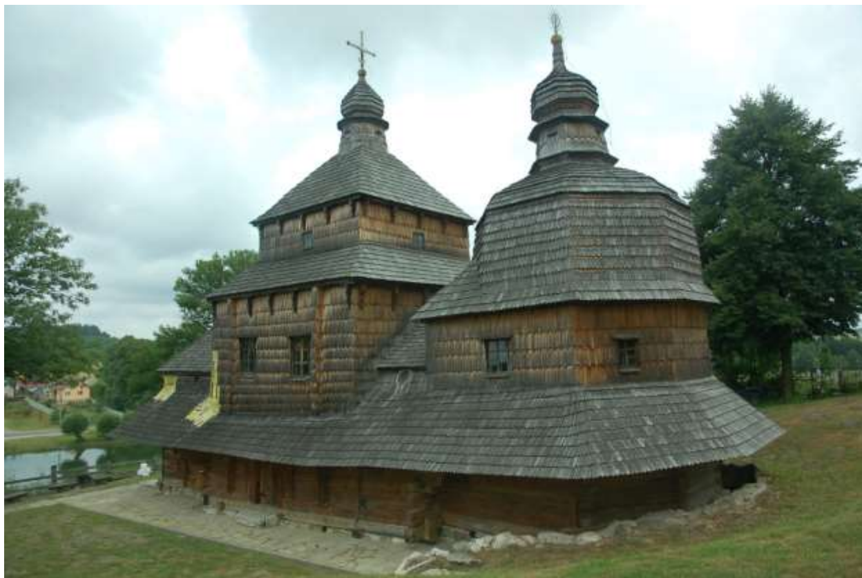
Рис. 11. Церква після завершення першого етапу реставраційних робіт. Фото 2020р.
