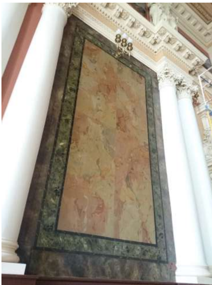
Рис. 13. Перший очищений та реставрований фрагмент автентичної малярської декорації у західному центральному міжколонному простінку; 2016 р. Виконаний на основі висновків та рекомендацій першого етапу досліджень. Фото С.Гетьманчука.
