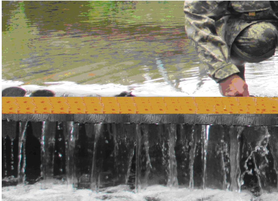
Рисунок 5.8 - Конструкція типу «біореактор» на основі волокнистого носія «ВІЯ» та дерев'яних споруд «кашиць»
