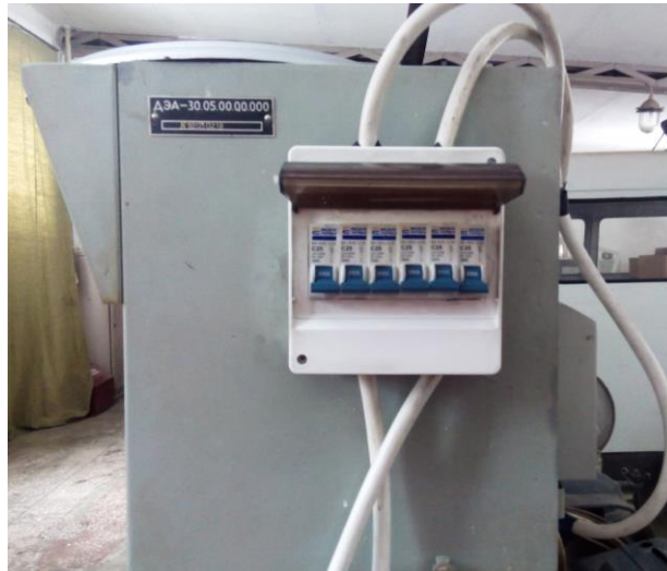
Рисунок 3.4 – Блок керування потужністю споживачів електроенергії
