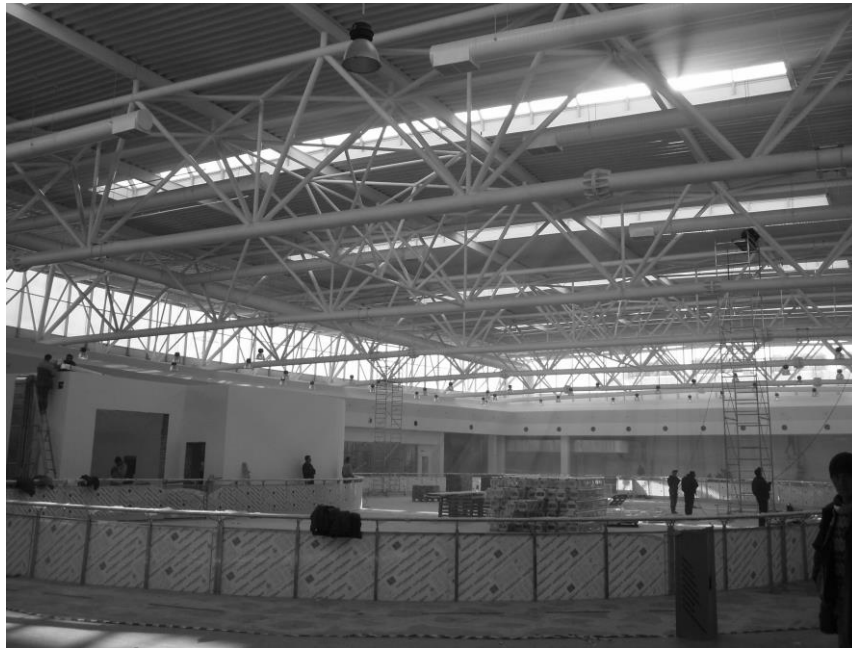
Рис. 5.10. Загальний вигляд конструкцій торгово-розважального комплексу
