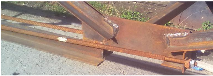
Рис. 2. Попередній натяг металевої шпренгельної конструкції на стадії виготовлення: а) – вузол шпренгельної затяжки; б) створення попереднього натягу
