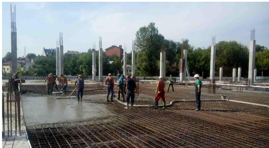
Рис. 5.4. Бетонування монолітного перекриття
