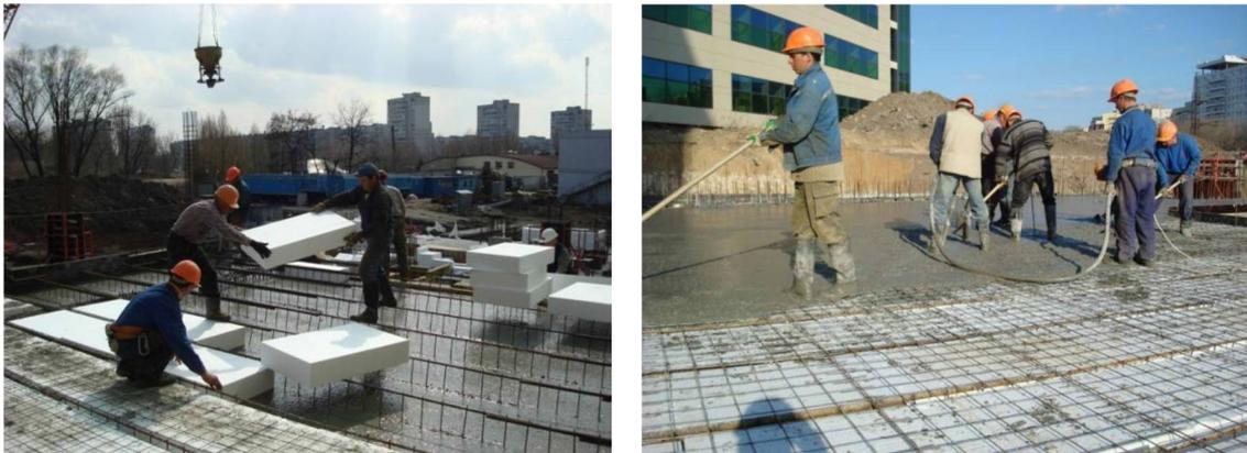
Рис. 1.8 Влаштування полегшеного перекриття з пустотоутворюючими вставками з пінополістиролу в розважальному центрі “Місто” у м.Харкові.
