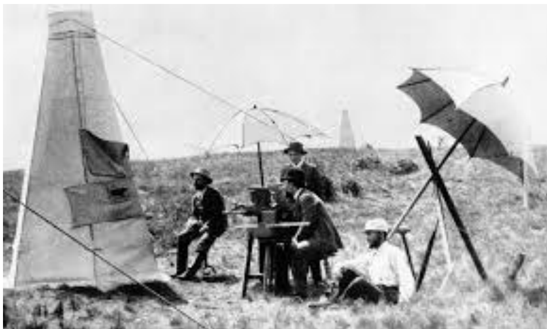
Рис.1.7 Лоранд фон Етвеш під час дослідження роботи крутильних ваг
