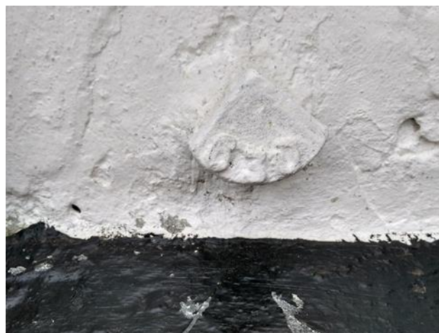
Рис. 2 Стінний репер №630
