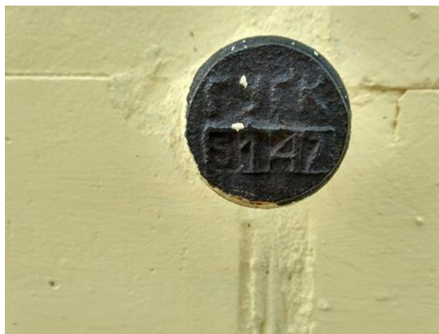
Рис. 1 Стінний репер (Пошта)
