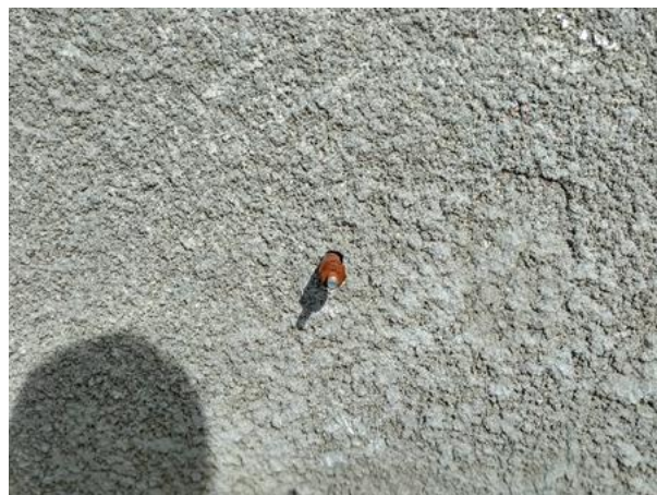
Рис.22 Стінний репер б/№ (Школа)
