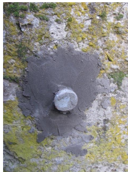
Рис. 2.23 Стінний репер б/№ (Міст-3)
