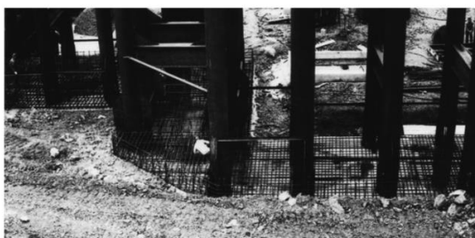
Рис. Г.5. Конструкція підпірної стінки розвантажувального майданчика в кар'єрі Полтавського ГЗК [139].
