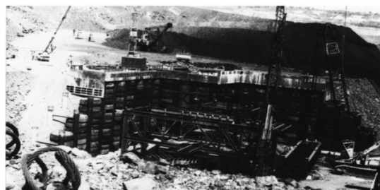
Рис. Г.5. Конструкція підпірної стінки розвантажувального майданчика в кар'єрі Полтавського ГЗК [139].
