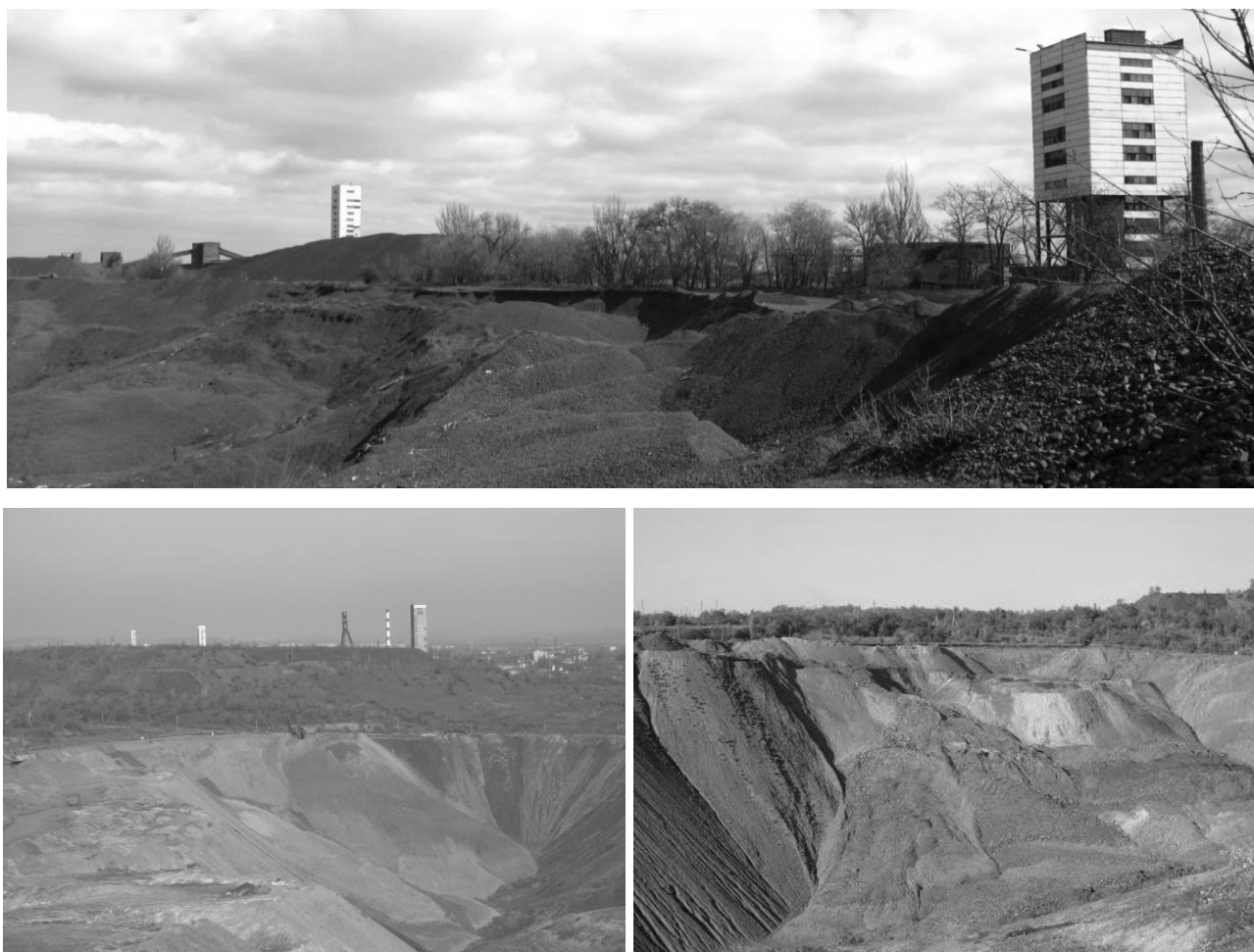
Рис. 1.2. Засипка Глеюватського (№1) кар'єру ВАТ ЦГЗК пустою породою, Кривий Ріг.
