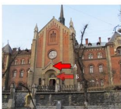
Церква св. Івана Златоуста (колишній костел Найсвятішого Серця Ісусового), вул. Лисенка, 43. Фото: Н.Піддубна, 2011
