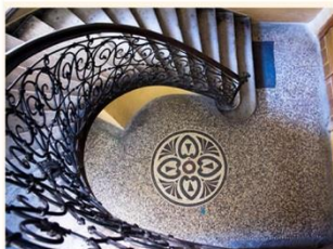
Мозаїчна підлога. Житловий будинок, вул. Ю. Словацького, 5. Фото: Н.Піддубна, 2017 р.
