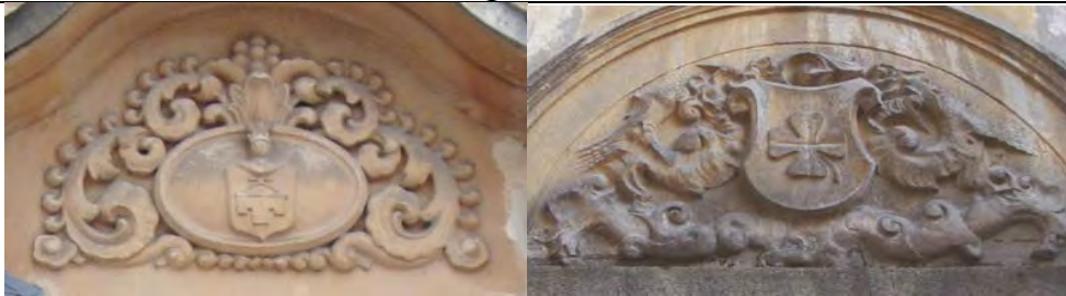
Вул. Ген. Чупринки 17, вул. Гарнавського 43
