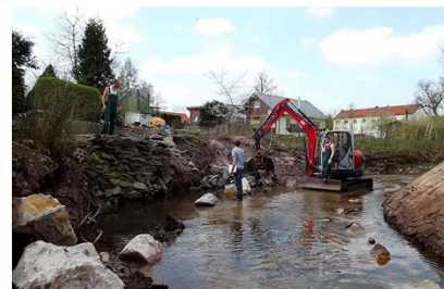
розчищення та укріплення русел
